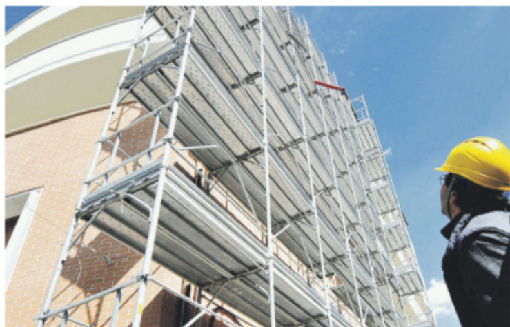
Un cantiere edile
